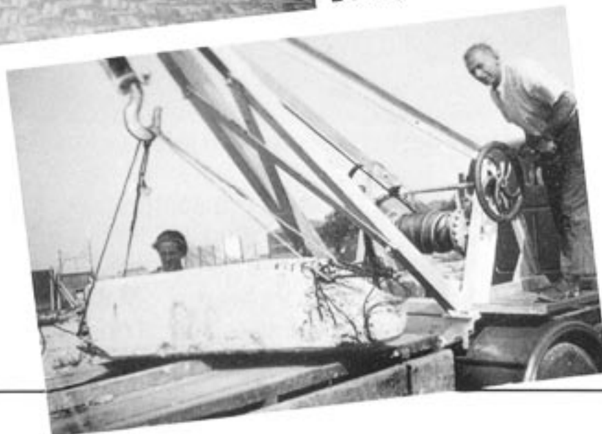
Thornicroft met verlengde mast tot 25 meter De zogenaamde Jo-Jo
